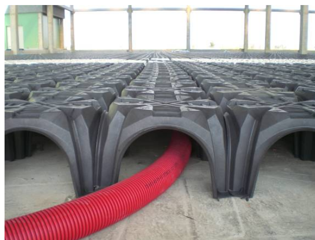
Fig. 2 Posa Modulo e passaggio tubazioni
