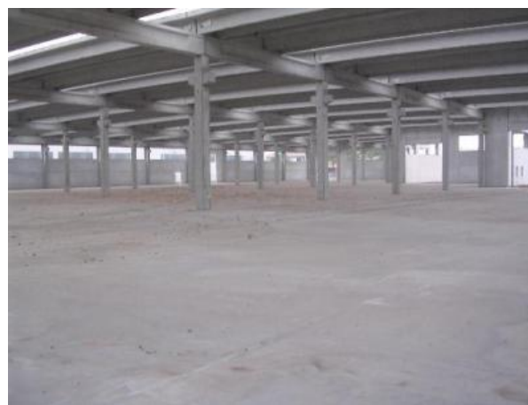
Fig. 4 Pavimentazione terminata
