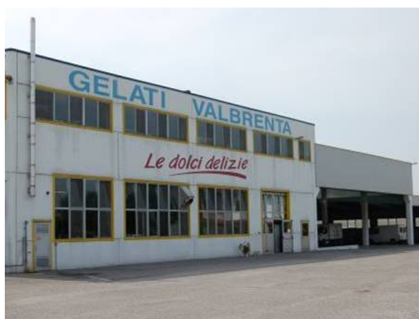
Fig. 1 Edificio visto dall'esterno
