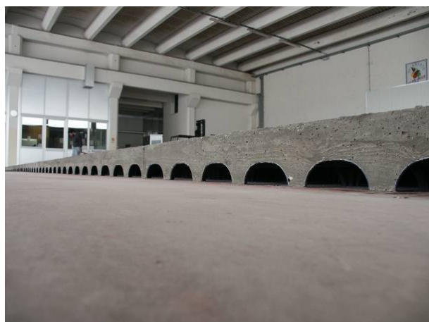
Fig. 3 Fondazione ultimata vista in sezione
