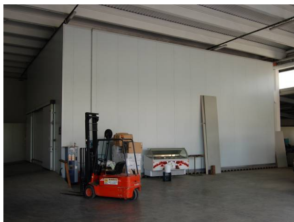
Fig. 4 Fondazione finita e cella posata
