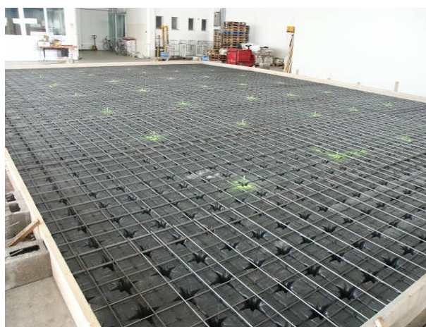
Fig. 2 Fine posa Modulo e posa rete
