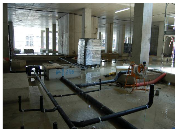
Fig. 2 Particolare posa tubazioni
