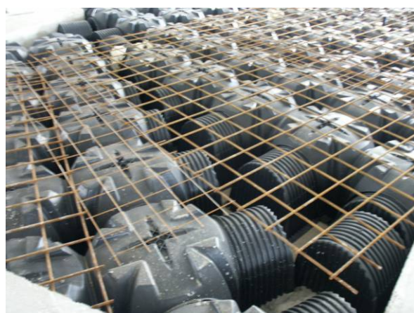
Fig. 3 Particolare cambio angolazione con utilizzo di Geoblock
