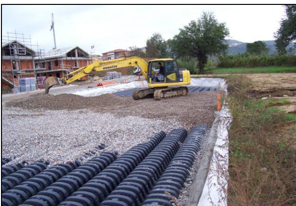
Fig. 3 - Ricoprimento con ghiaia
