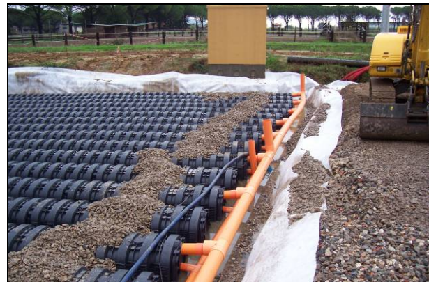
Fig. 2 - Particolare dell'innesto dei tubi
