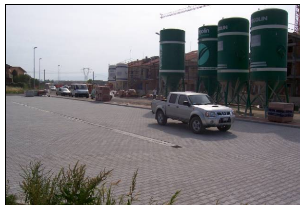
Fig. 4 - Parcheggio finito con autobloccanti
