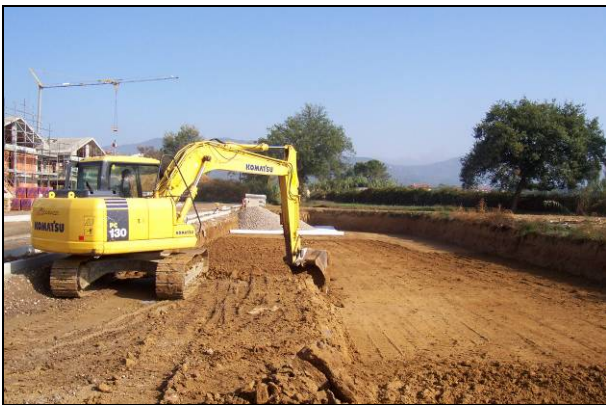
Fig. 1 - Preparazione dello scavo
