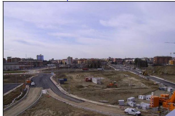
Fig. 4 - Copertura completa con terreno di riporto
