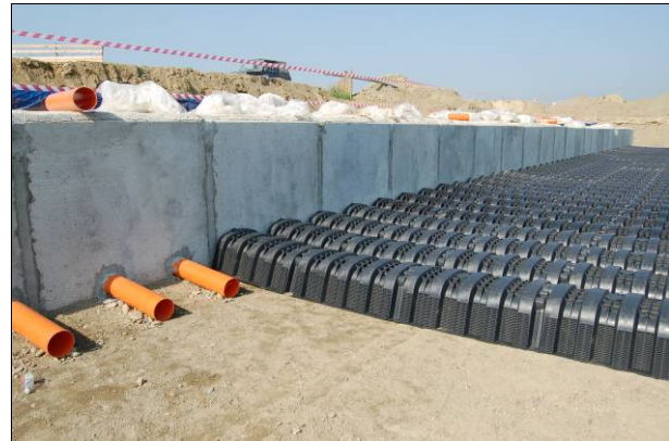
Fig. 2 - Collegamento tra bacino Drening e cavedio di mandata dell'acqua
