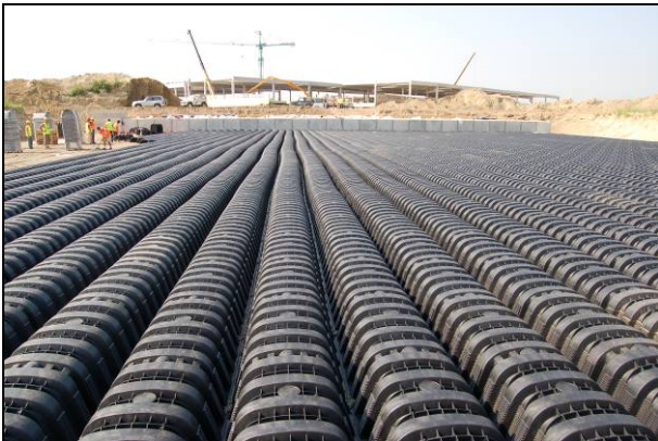
Fig. 1 - Posa delle camere Drening
